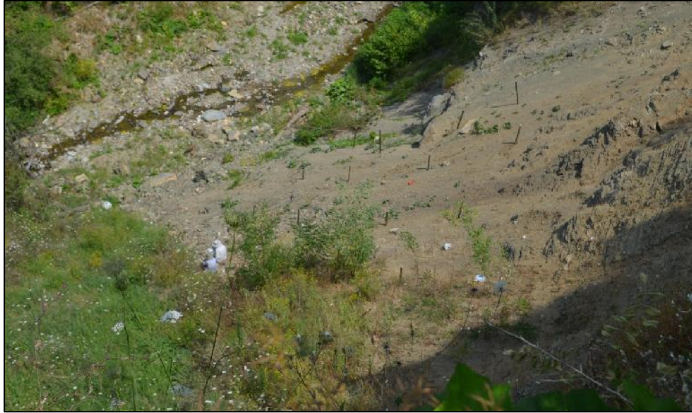
ekil 10. Kablo sabitleme noktalarının heyelan tacından görünümü
