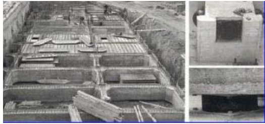
Resim 2.8. 297 yüksek sönmüleyici kauçuk mesnet, inşaat başlangıcı, 1988
