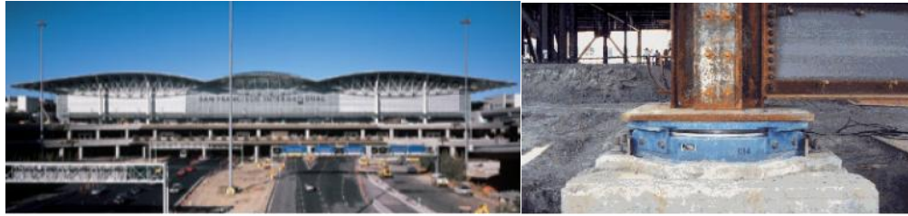
(a) (b) Resim 2.5.a. San Fransisko uluslararası havaalanı terminali b)Sürtünmeli sarkaç mesnet
