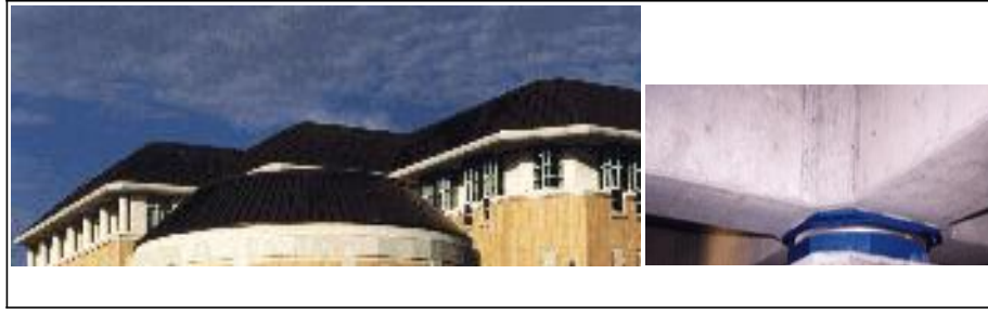
(a) (b) Resim 2.4. a) Hayward belediye binası b) Sürtünme sarkaçlı mesnet
