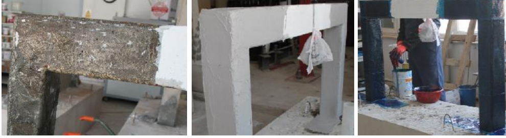
ekil 4. Yapısal onarım a amaları
