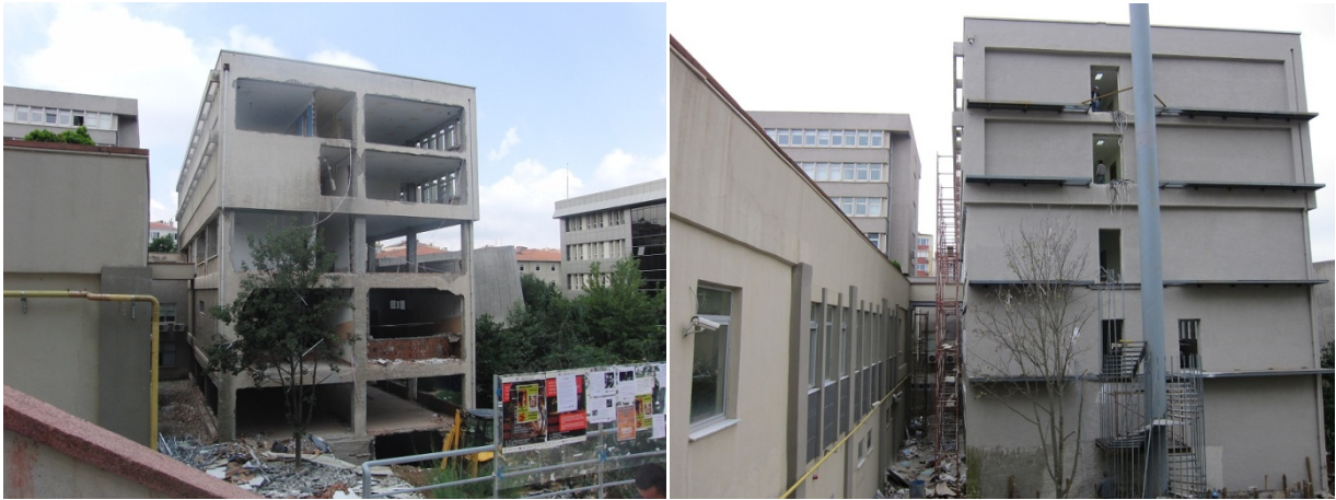
Şekil 1 Güçlendirme öncesi ve sonrasında ET-B binası
